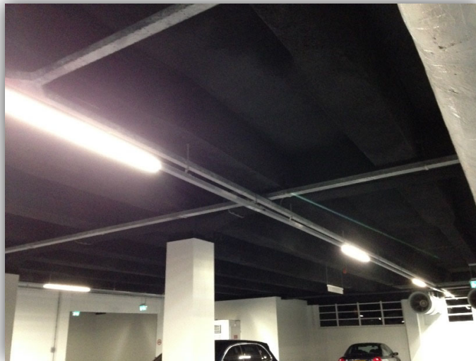
1: SEDIPHONE DONKERGRIJS OP PLAFOND IN PARKEERGARAGE
